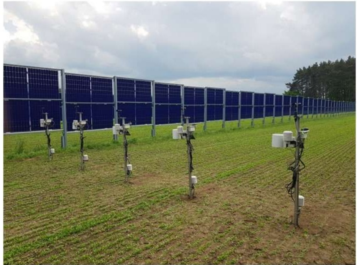
Installierte Wetterstationen am 21.5.25
